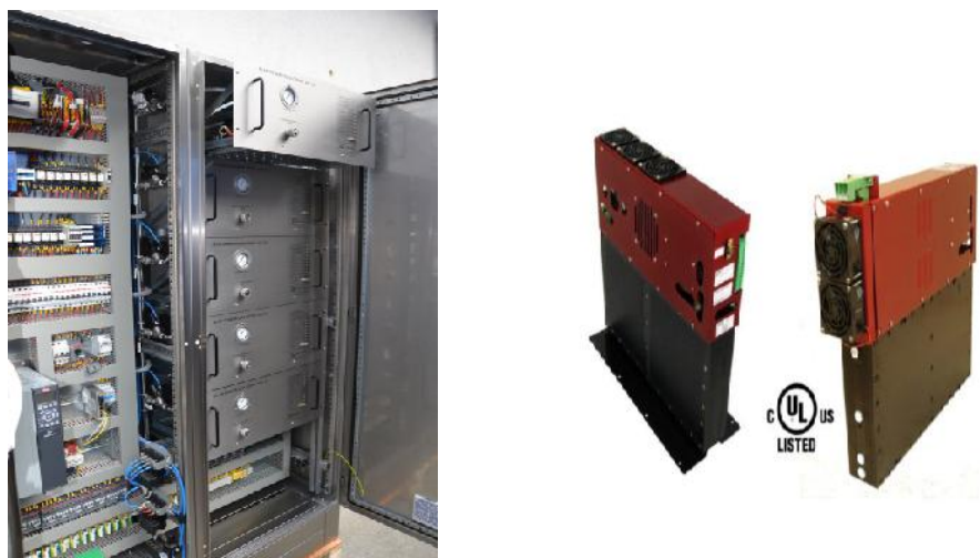
Rys. 1. Przykłady nowoczesnych ozonatorów pracujących w technologii nietermicznej plazmy FIRMY WOFIL i PINNACLE OZONE SOLUTIONS.
